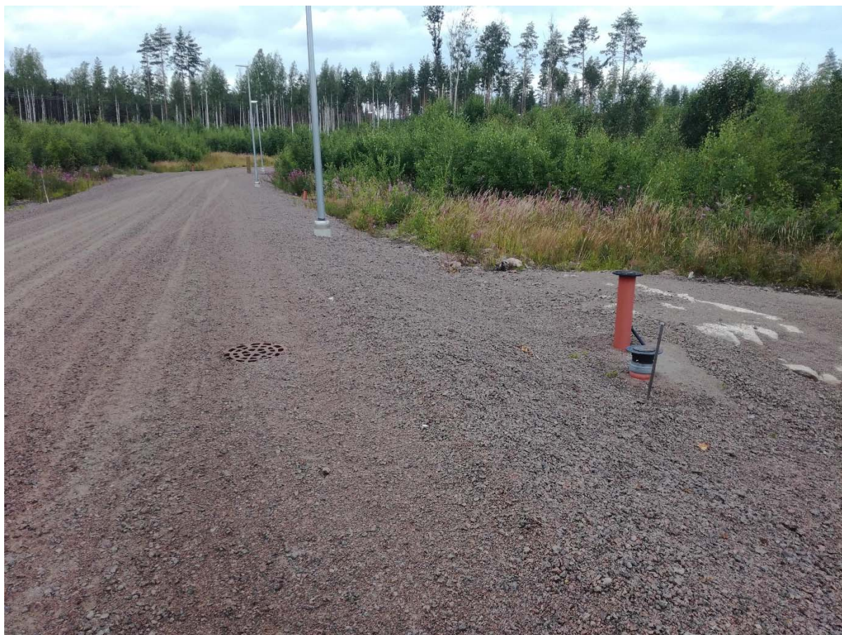
Kuva 3 Uudiskohteeseen on rakennettu vesihuoltoverkosto tien alle. Kuvan oikeassa reunassa on vesihuollon tonttiliittymä, joka sisältää jätevesiviemärin ja tarkastuskaivon, vesijohdon sekä vesijohdon sulkuventtiilin. Tontti odottaa rakentajaa.
