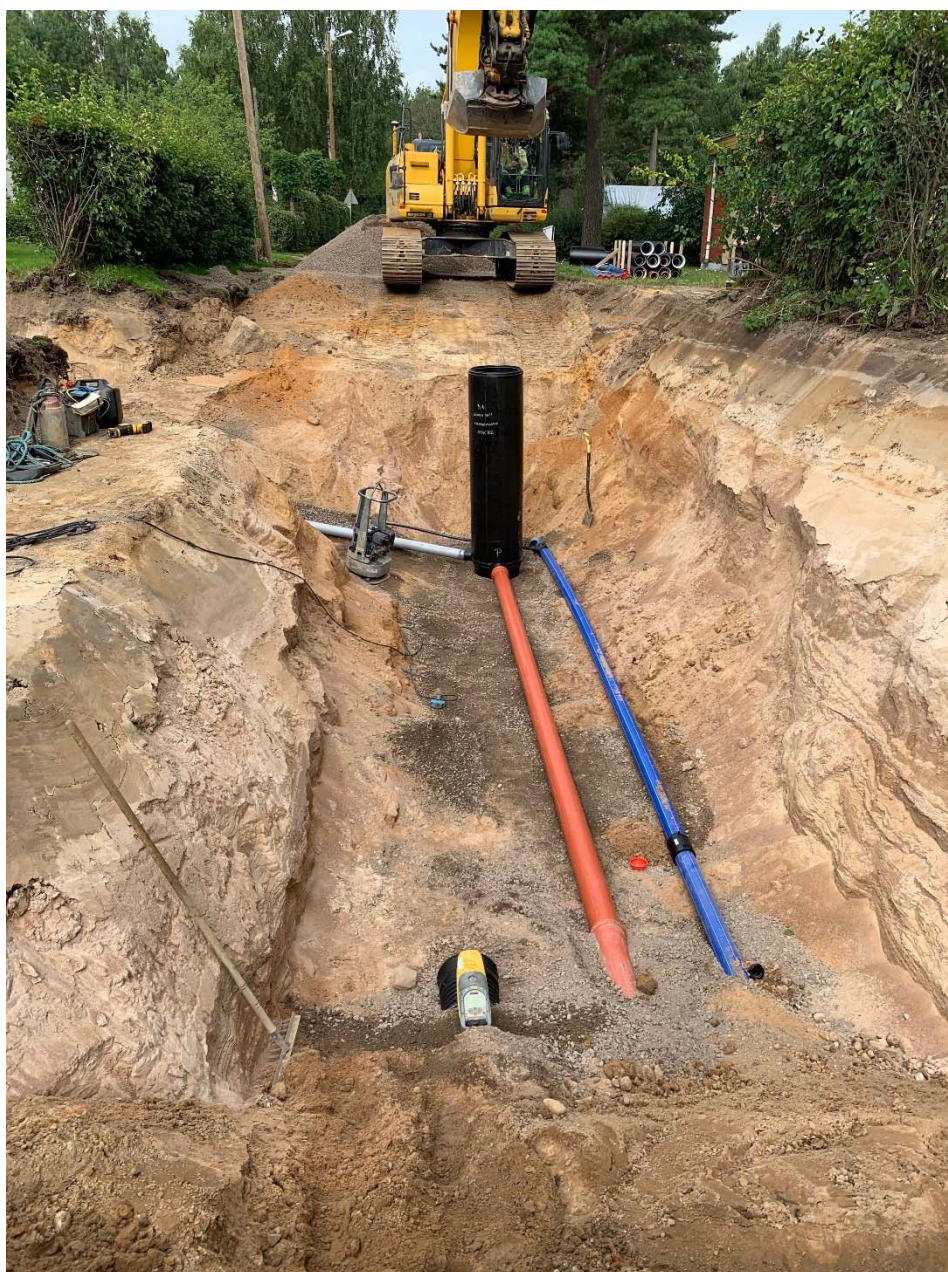
Kuva 2 Putkikaivanto. Sininen putki on vesijohto, ruskea jätevesiviemäri ja musta, keltaharmaan laitteen alta näkyvä putki hulevesiviemäri.
