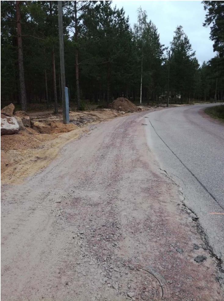
Kuva 4 Olemassa olevan tien reunaan on rakennettu uudet vesihuollon putket, ja tien reunassa näkyvään metsään on kaavoitettu uusia tontteja, joille on tehty liittymät verkostoon. Koko tietä ei tarvitse kaivaa auki putkien asennusta varten.
